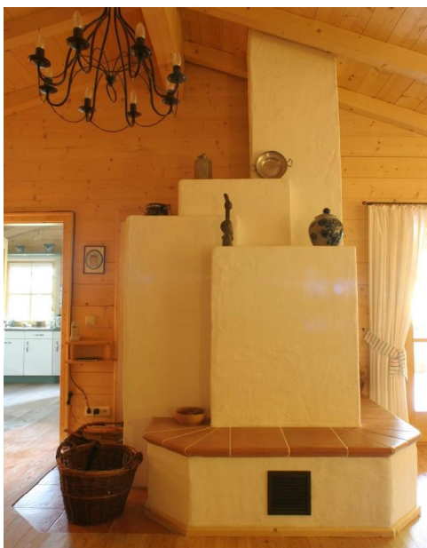
Grundofen mit beheizter Ofenbank - 1,5 t Schamotte-Speicher-Masse, ca. 5 Laufmeter gemauerte Züge
