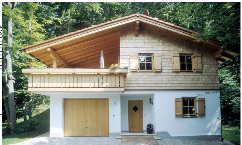
Das Originalhaus erhielt an der Wetterseite eine Zusatzdämmung mit Schindelverkleidung
